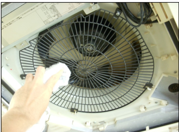
■ エアコンの室内機清掃 (2021年5月撮影)
