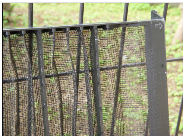
■ エアコンのフィルター清掃 (2021年5月撮影)
