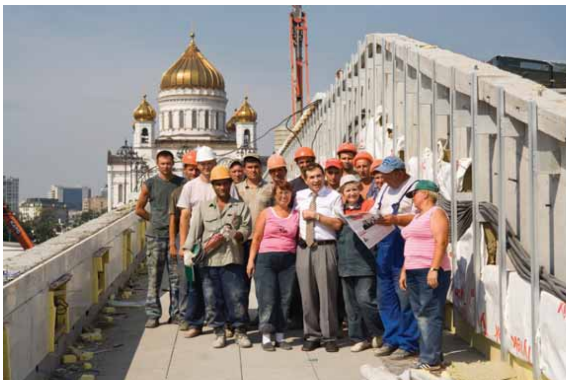
На строительстве Патриаршего моста к Храму Христа Спасителя. Встреча с бригадой рабочих «Союзметроспецстроя».
