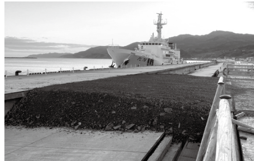
写真－2 応急復旧による仮設道路設置状況及び支援船接岸状況 (左：飯田港、右：輪島港)
