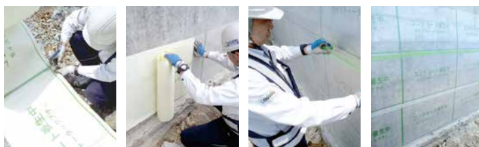
1. カット 2. 貼付け 3. テープ補強 4. 完成
