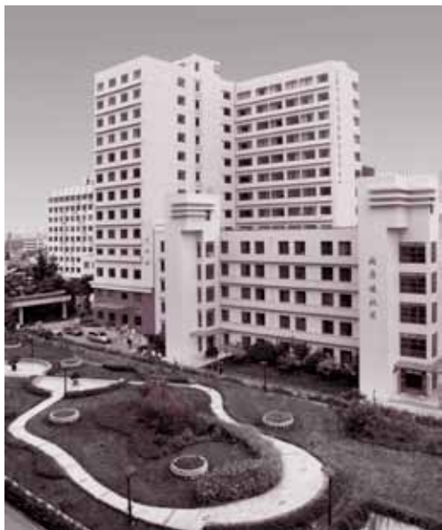
创伤骨科病房大楼竣工
