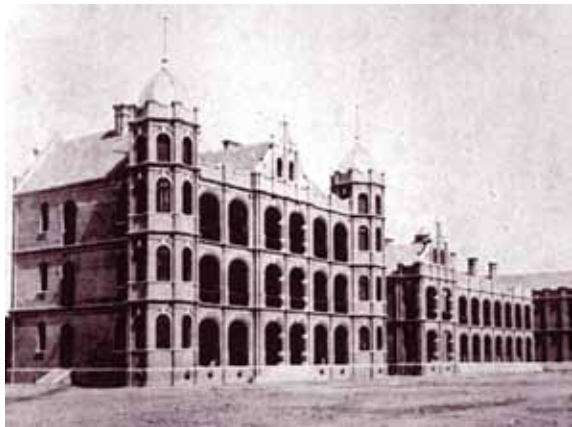
西人隔离医院新竣工的病房楼东楼和办公楼
