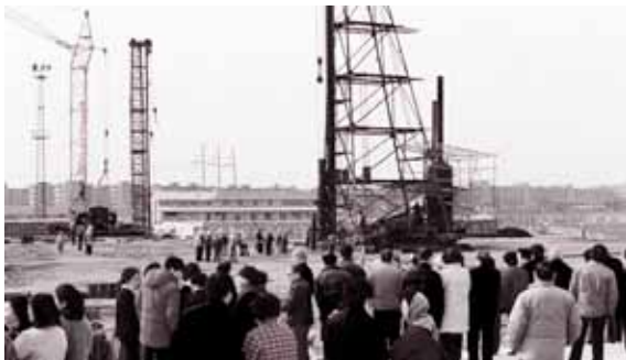
新医院迁建工程开工典礼(病房楼打桩)
