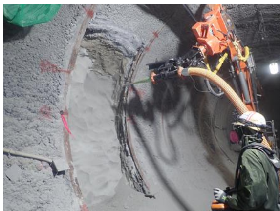
図 2B-9 止水プラグの切欠き部に対する吹付けによる施工試験 (幌延深地層研究センターの深度 350m 調査坑道) (2021 年度)
