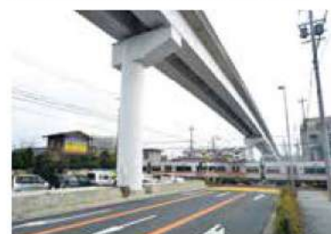
丸形鋼製橋脚と鋼製箱桁
