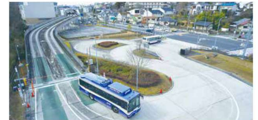
高架区間と平面区間を同一の車両で走行するため、両区間の接点には、機能変換、確認を行うための施設としてモードインターチェンジを設置
