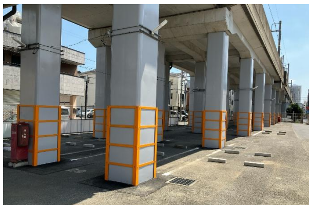
＜高架橋耐震補強工事例 (弘明寺～上大岡駅間)＞
