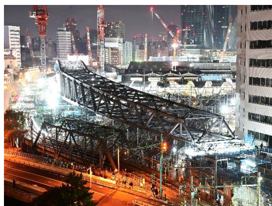
&lt; ハツ山跨線々路橋の架設状況 &gt;
