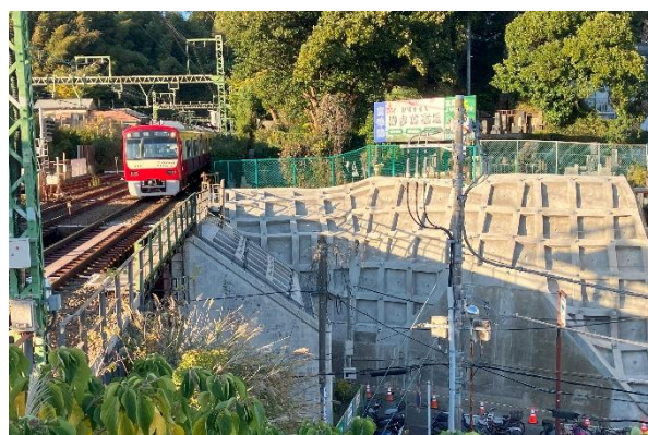
＜法面防護工事例 (杉田～京急富岡駅間)＞
