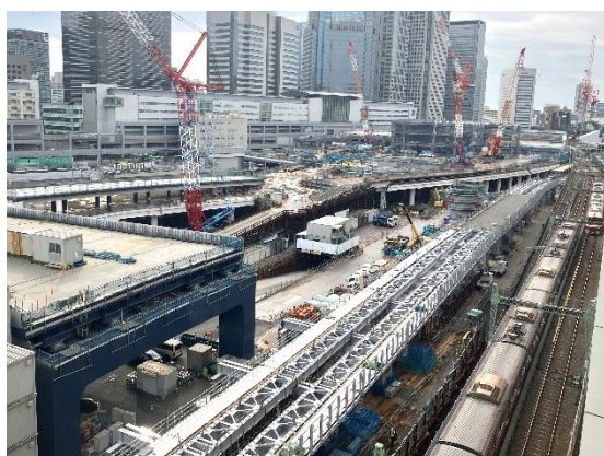
&lt; 仮線高架橋の構築状況 &gt;
