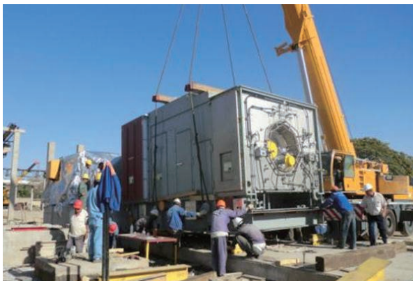
Fig. 6 ガスタービン据付状況
