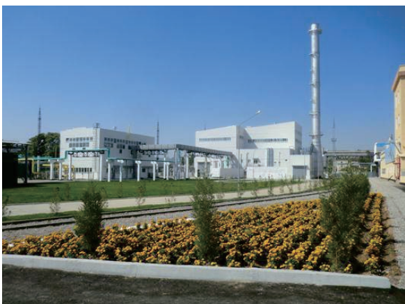
Fig. 3 実施地点と完成した発電プラント全景
