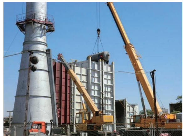
Fig. 7 ボイラドラムの設置作業状況
