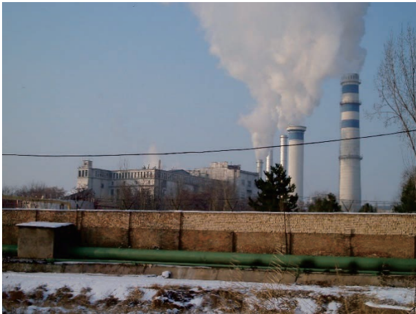
Fig. 2 タシケント熱電併給所
