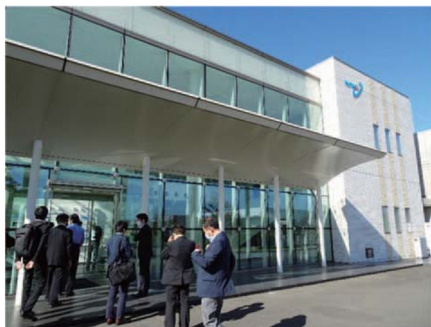
Fig. 9 水素エネルギー製品研究試験センター
