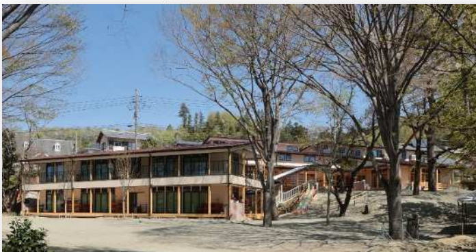
2021年3月新園舎完成
