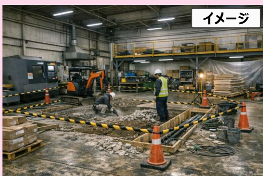
▲ 改修工事の施工が確認できる写真
