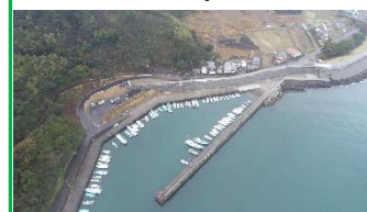
現地状況写真 (R6年1月)
