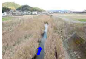
苗代橋より下流河道
