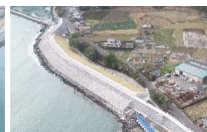
現地状況写真 (R4年3月)
