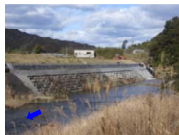
仁井田橋上流側 右岸の護岸 (令和3～5年度施工)
