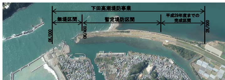
現地状況写真 (R2年1月)
