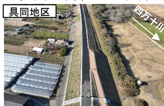
現地状況写真 (R6年1月)
