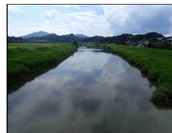
河道掘削状況【18K/020付近】
