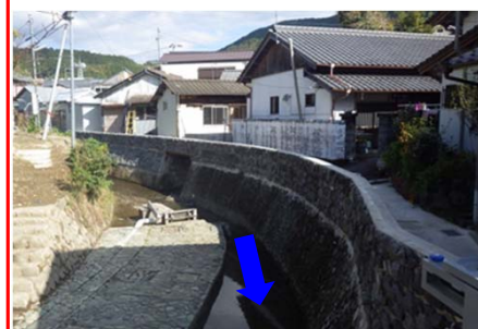
琴平谷川 (護岸嵩上げ)
