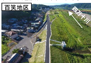
現地状況写真 (R4年7月)
