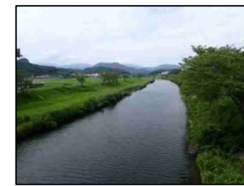
樹木伐採状況【19K/350付近】
