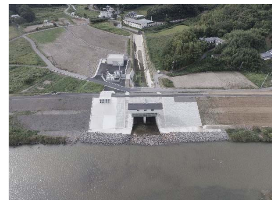
令和5年6月完成
