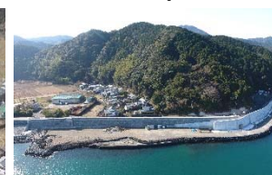
現地状況写真 (R6年1月)
