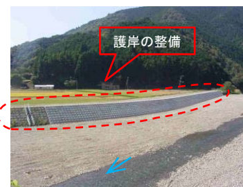
H25.9 (護岸整備直後)
