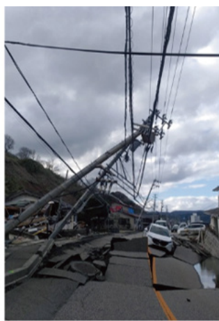
地震により倒壊した電柱(2024年1月能登半島地震)
