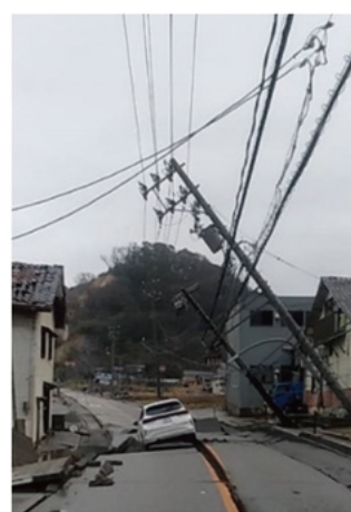
地震により倒壊した電柱(2024年1月能登半島地震)
