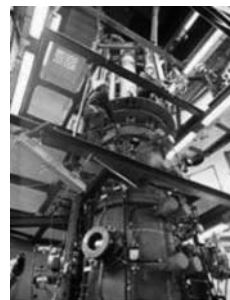
図8 アーヘン工科大学酸素燃焼試験装置（出所：RWTH-Aachen University, Courtesy of (c) Peter Winandy.）
