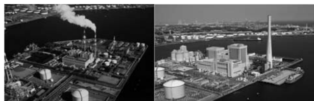
図6 旧磯子火力発電所(左)と新磯子火力発電所(右)
