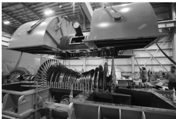
図20 据付中の140MW地熱用蒸気タービン
