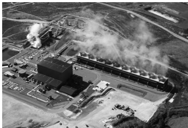
図21 NAP地熱発電所全景
