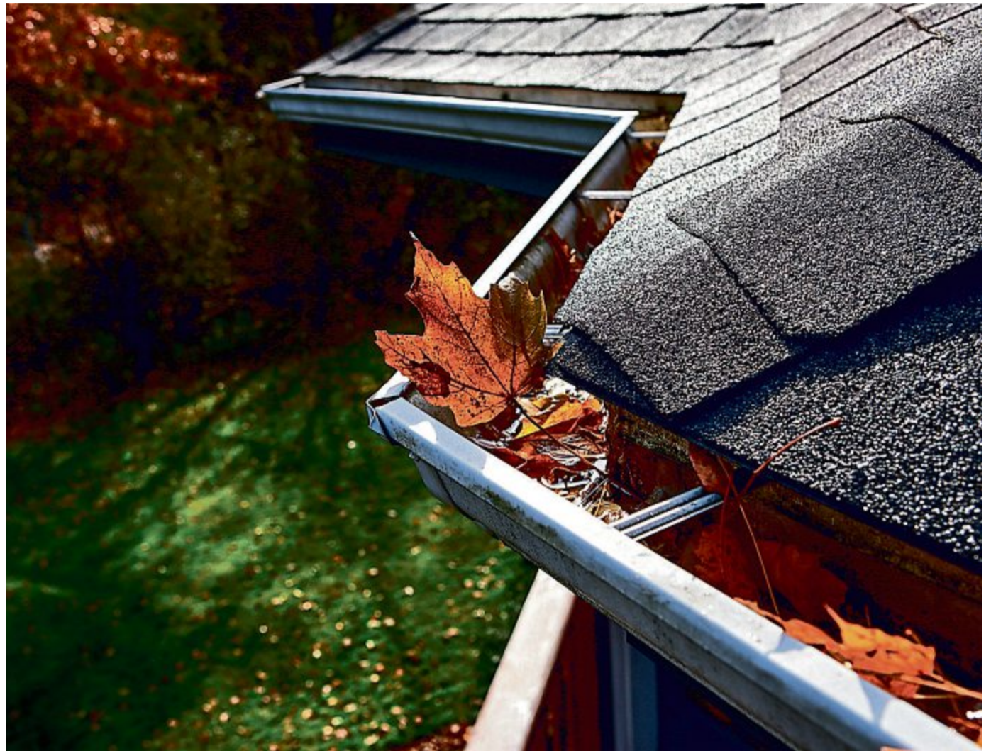
Eine Reinigung der Dachrinne gehört auch zum DachCheck.
