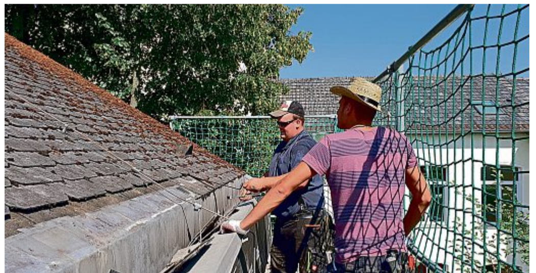
Verklammerung und Befestigung der Dachziegel bzw. -platten werden beim DachCheck geprüft.
