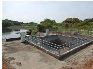
写真3 農業用ため池の洪水吐
