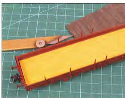
De op maat gemaakte tape wordt in de wagen gekleefd, daarna verwijderen we het schutpapier en kan de bodem aangebracht worden.
