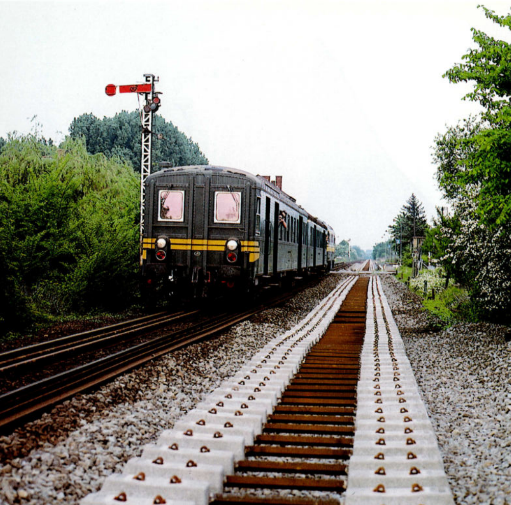
12. Les travaux préparatoires à l'électrification de la ligne 97 entre Saint Ghislain et Quiévrain progressent à toute allure. On peut en juger sur cette photo prise à l'occasion du voyage spécial organisé par le GTF, le 8 mai. Les nouvelles traverses en béton sont en cours de pose sur la voie A, tandis que la voie B (sur laquelle circule précisément le train spécial du GTF) sera désaffectée après renouvellement et électrification de la première. Conséquence: pour l'instant, la ligne est déjà exploitée à voie unique et au moyen de signaux mobiles en direction de Quiévrain ! Thulin, le 8 mai 1993. Photo: Max Delie.
