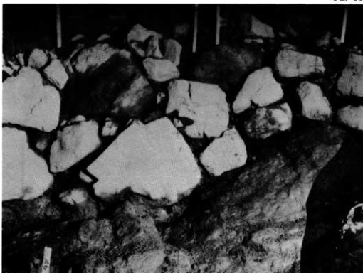
1. VI区ポンプ室石垣岩盤状況
