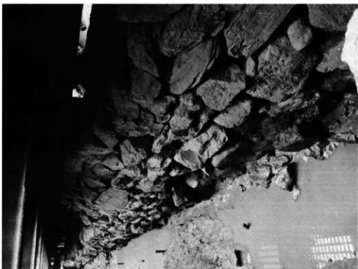
2. VI区石垣 (東より)
