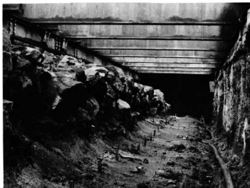
2. Ⅲ区石垣 (西より)
