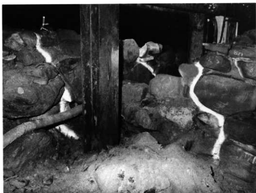
2. IV区石垣入隅保存部
