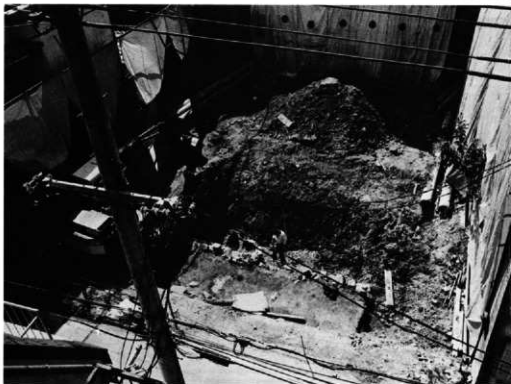
PL. 1 赤坂1丁目石垣調査風景
