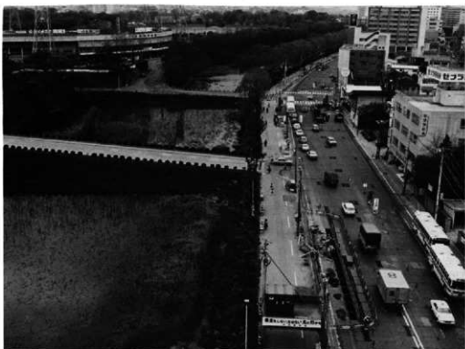
2. 調査地点遠景 (Ⅶ区) 左上は平和台球場
