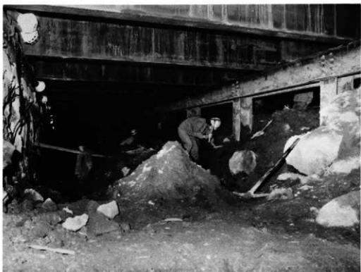
2. IV区石垣清掃作業風景
