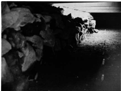
2. I区石垣（西より）
