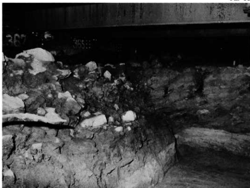
1. IV区第2トレンチ裏込め
