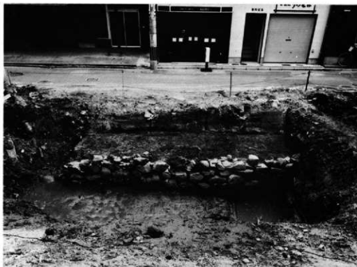
PL. 2 石垣露呈状況 (西から)
