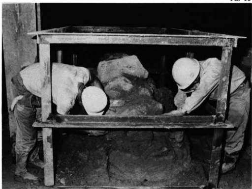
1. IV区石垣入隅部保存作業
