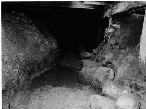
1. Ⅷ区石垣 (東より)
