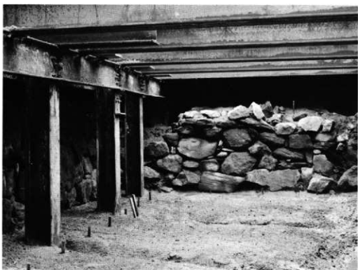
2. IV区石垣入隅部（西より）
