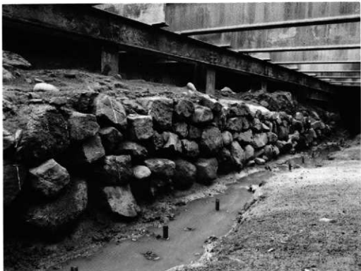
1. Ⅲ区石垣（西より）
