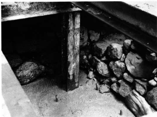
1. IV区石垣入隅部（南西上より）
