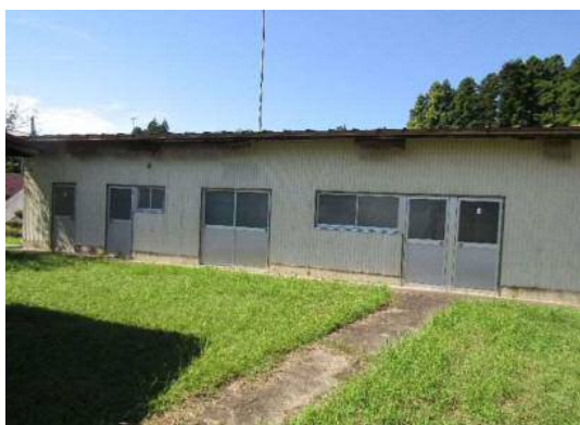
プール機械室棟
