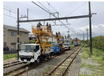
架線設備張替（内房線）
