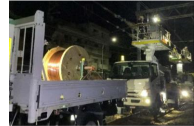
架線設備の修繕作業
