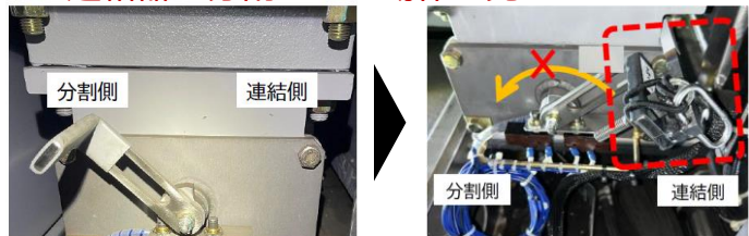
空気管開閉器 (分割状態)
