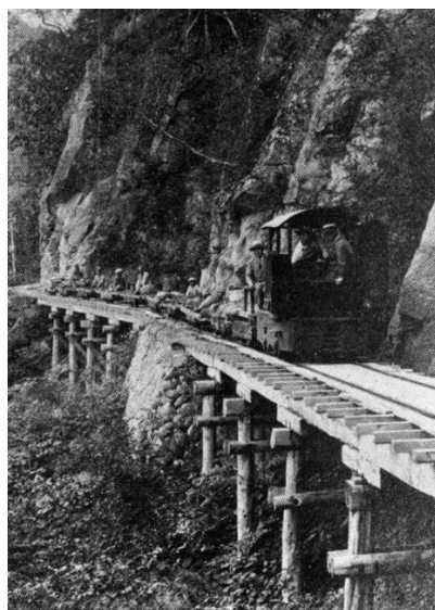
図 1-19 白土式発生装置を装備した Whitcomb 4 トン機関車の活躍
