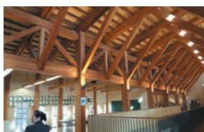
最深積雪量が2mという多雪地域で、国産のカラマツ集成材を使用した方杖形式のラーメン架構である。木材が露出となる部分では燃え代設計を行い、部材断面を決定している。2階末までをRC造とすることで、上下階の遮音性に配慮している。
