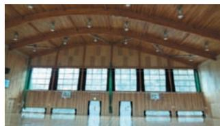
ステージ、玄関、更衣室などをRC架構として両端部に配置し、長手方向に偏平な曲線の梁を架けている。偏平なアーチ梁の端部に生じる水平方向に広がろうとする力(スラスト)は全てRC架構で処理される。
