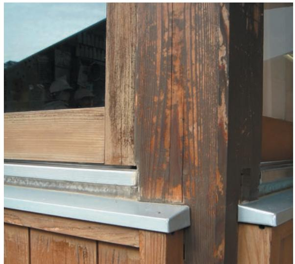
外部材料の紫外線による劣化（柱・木製サッシ枠回り）
