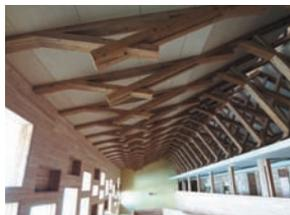
階段や便所、機械室などをRC造とし、このコアを繋ぐように木造の架構を設置する形式である。この例では、RC造コアを設置し、各棟ごとに地震力や風圧力の大半を負担させる計画となっている。長野県の代表的な製材であるカラマツを中心に使用し、合板充腹梁や重ね梁といった架構の工夫が見られる。
