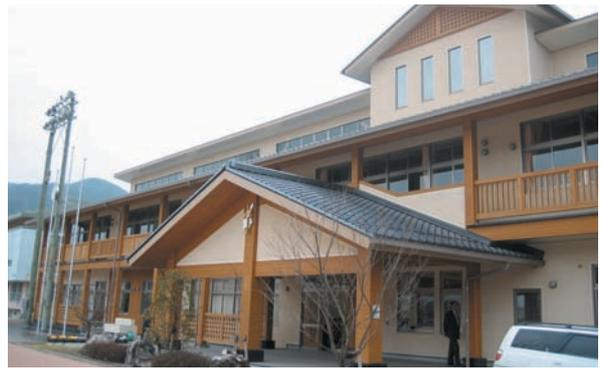
山口県山口市立徳地中学校・主要構造部が準耐火構造で、建築物周囲に3m以上の通路を設けた例
