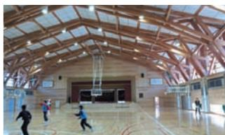
棟部分をピン接合とし、集成材によるトラス架構をダブルに架けている。トラスの脚部はRC造の片持柱で支持し、桁方向をRC造のBOX梁を架ける構造計画となっている。
