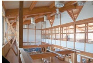
能代市は木材の町で、5校の木造校舎の実績がある。地域材による集成材と製材品の組合せで、接合部には金物を使用している。そのほか工事を分離発注することで、地元企業の技術者の育成にも配慮されている。
