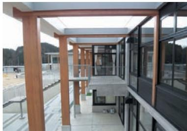
集成材を鉛直荷重の支持材、RCを水平力に対する抵抗部材として構造計画がなされている。この例は、RC造コアを集成材架構で覆う形になっている点が特徴的である。RC造は遮音性への配慮も兼ねている。また、地場産の丸太材を柱に使用したり、内装材にも地場の木材を多用している。
