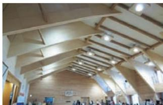
ステージおよびホワイエ部分をRCコアとして、延焼防止の役割と水平力の大半を負担させている。主架構は長野県産のカラマツ120mm角材を接着重ね梁・重ね柱として組立てている。プレカットと手加工を併用し、継手には追掛大栓や金輪などの伝統的な構法も採用されている。
