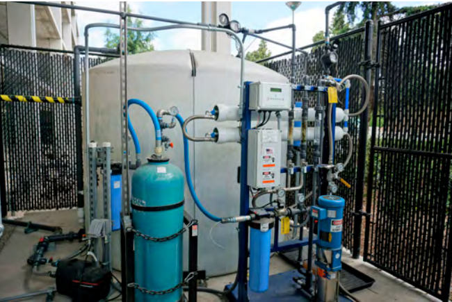
SELのサンディエゴオフィスが敷地内に設置した地下水処理設備
