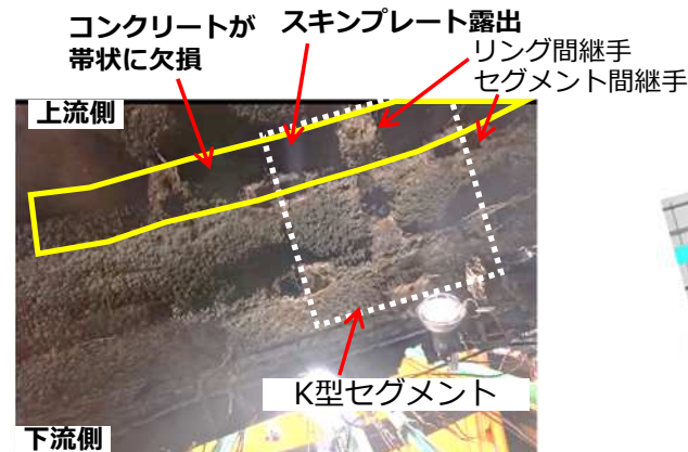
写真② シールド外殻内のRCセグメント詳細
