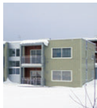
分別解体しやすい外断熱工法
