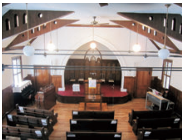
2階礼拝堂。水平方向にタイバーを使って美観に配慮
