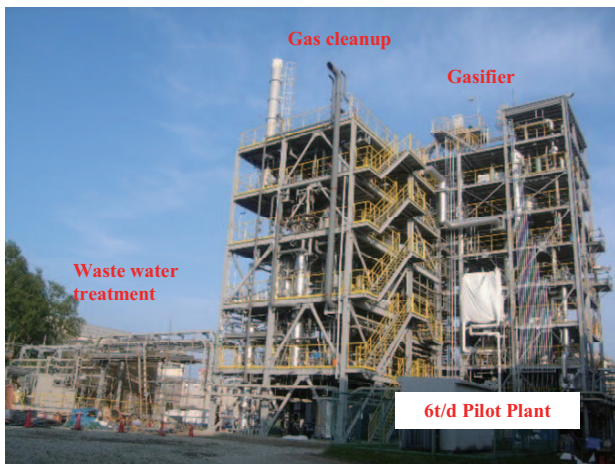
図8 TIGAR®パイロット炉
