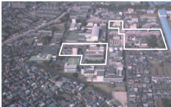
図1 調布航空宇宙センター（枠内：エンジン関連施設）
