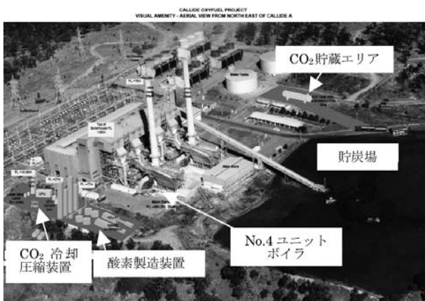
図3 カライドA発電所の全貌と主な酸素燃焼適用改造範囲
