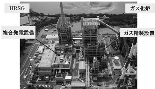
図8 IGCC実証機の全景
