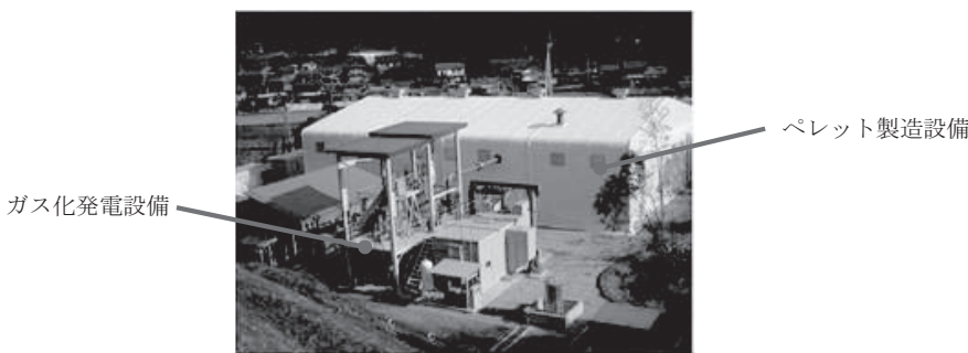
図7 実証試験設備 全景
