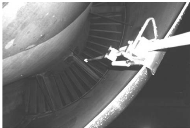
図6 取り付けられた洗浄Probe (エンジン後方より)
