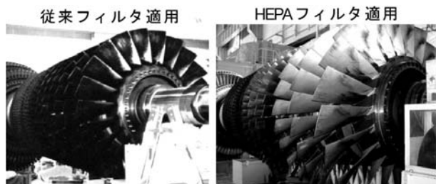
写真4 圧縮機翼の汚れ状況
