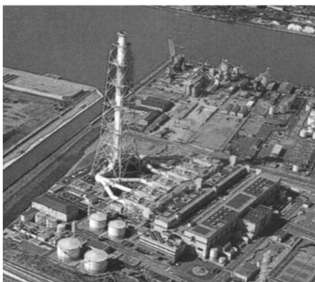
写真2 プラント全景
