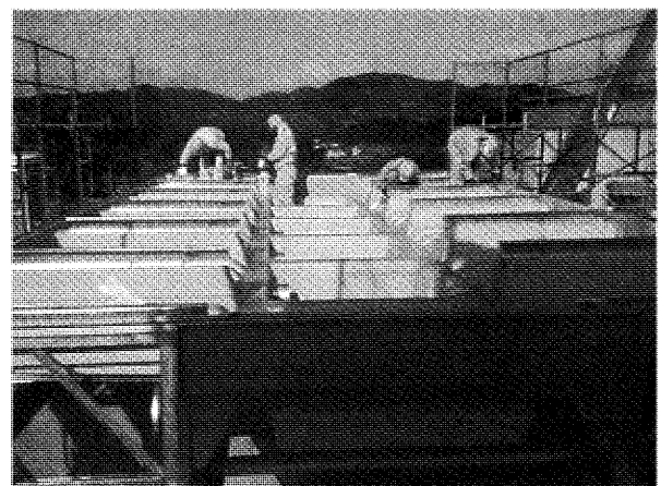
図6 下部水槽組立中
