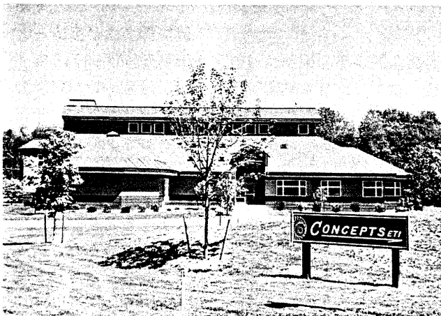
写真1 コンセプト ETI 社 本社全景
