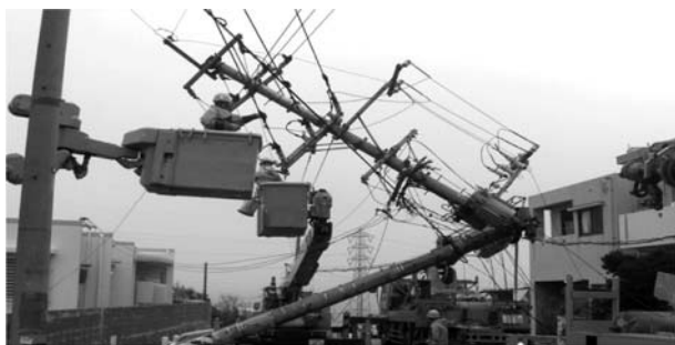
Fig. 8 配電設備の復旧作業
