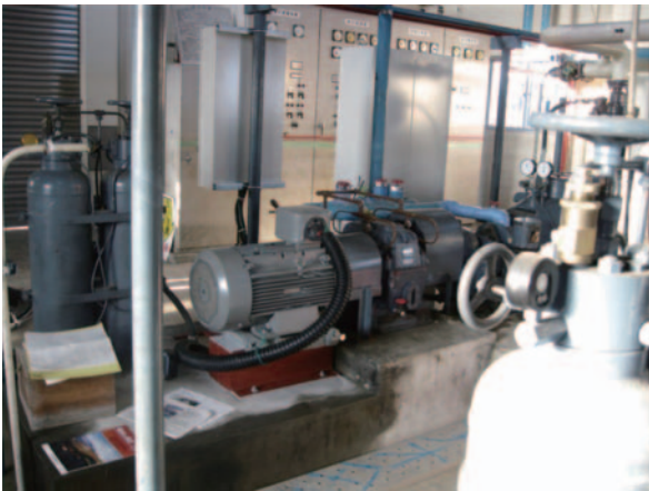
復旧状況（エンジ基础上に電動機を据付）
