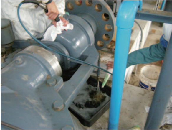
主ポンプ外軸受内部の砂除去作業
