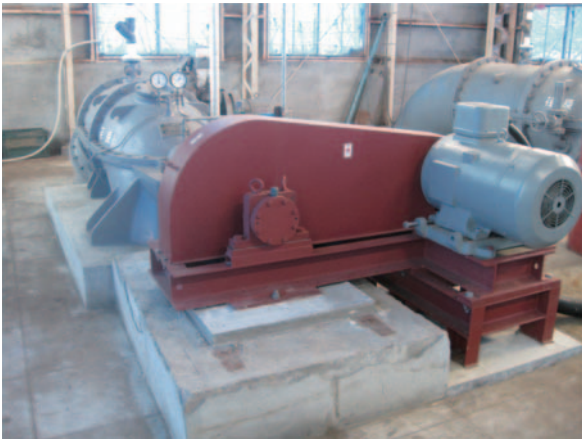
復旧状況（既設16P電動機 → 6P電動機＋ベルト掛け）
