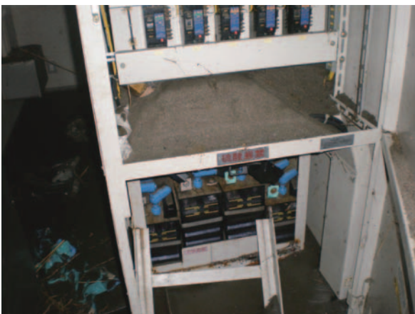
盤内に大量の砂が堆積
