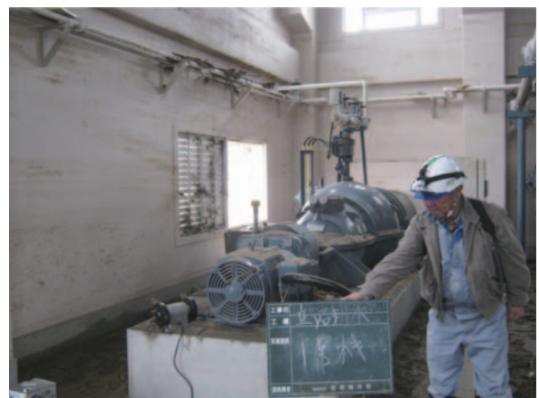
電動機被災状況
