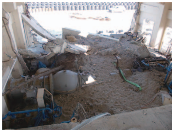
流入した砂で機器が埋没
