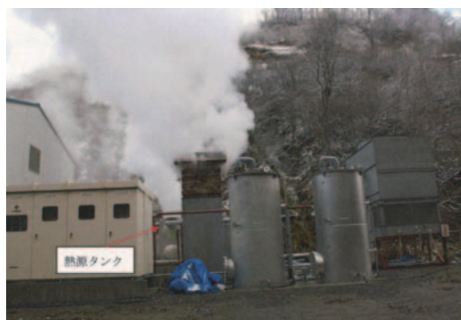
Fig.15 鷹の湯3号の蒸気と熱源タンク（実証運転時）
