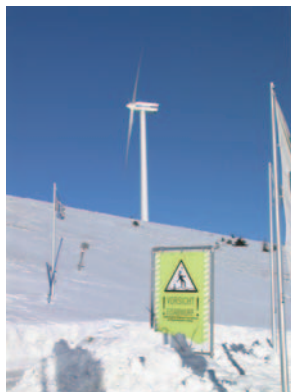
図8 着氷飛散の警告板
