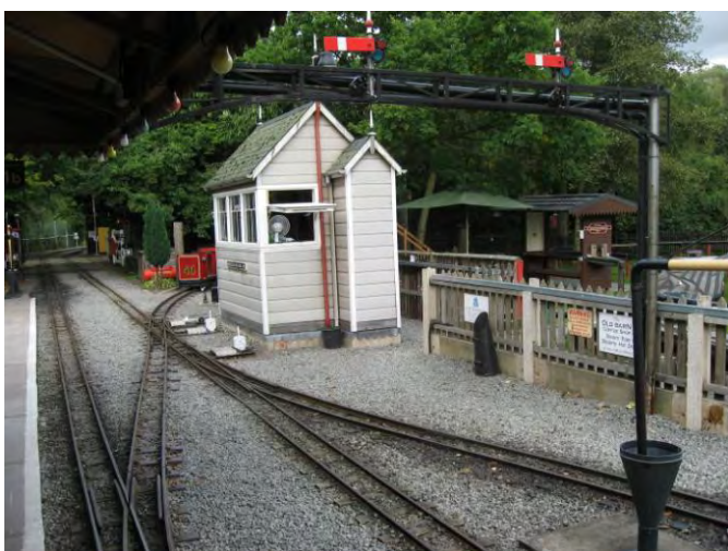
Un sympathique poste d'aiguillage, avec des manettes et des contrôles d'aiguilles et de signaux à faire baver d'envie Pierre et Jean-Pierre Vankerckhove du PTVF... Notez la petite potence avec ses signaux mécaniques.
