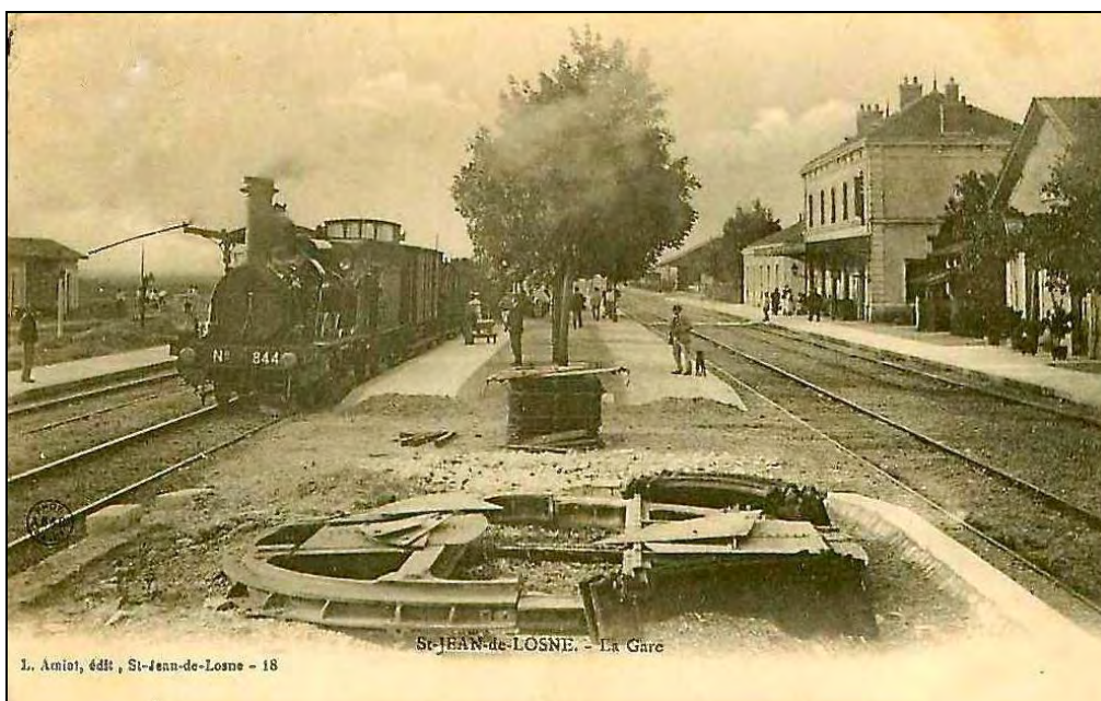
Cliché X - Edition Amiot à St. Jean-de-Losne Plaque tournante démontée et détruite. Remarquez aussi la vigie du fourgon de tête, juste derrière la locomotive.
