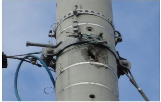
図3 電柱の被害例
