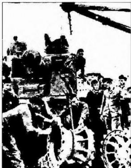
Замена ведущих колес. Как видно, процесс ремонта очень тяжелых деталей требовал серьезной помощи и был делом крайне нелегким.
