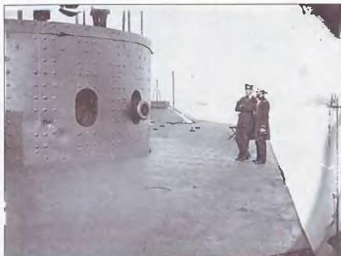
«Монитор» после боя. На рубке видны следы попаданий ядер, выпущенных с «Мэрримака»
