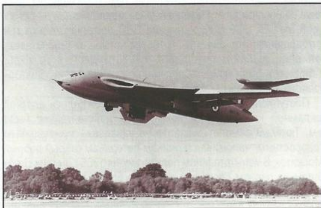
Взлетает второй опытный самолет HP.80 «Виктор» борт WB775 — хорошо видны выпущенные предкрылки и закрылки.
