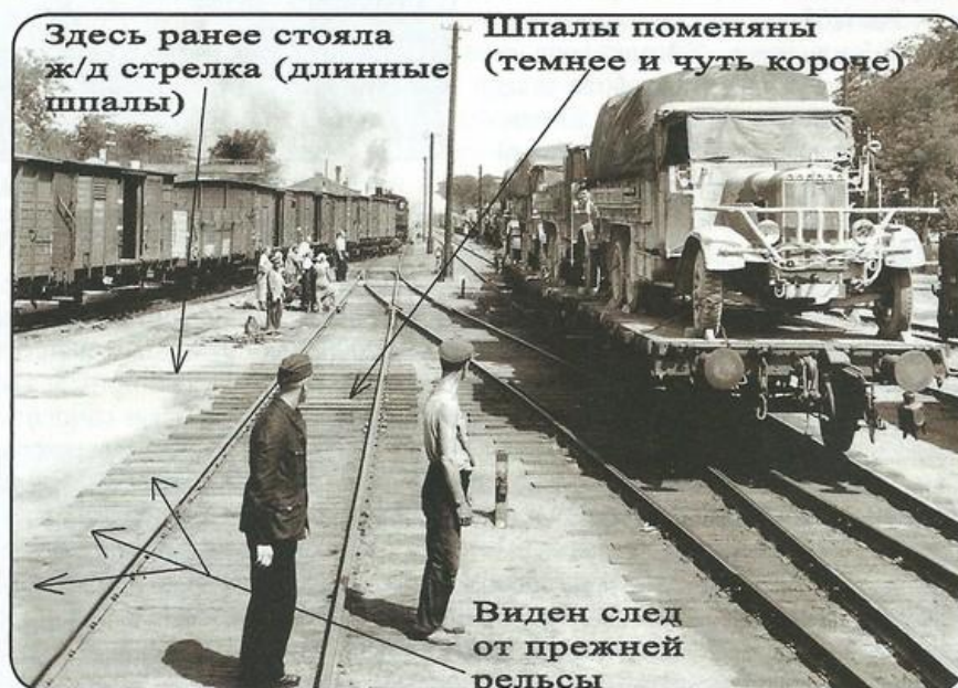
Редкая возможность встретить на одной фотографии почти все: перешитые рельсы и следы от советской колеи, Россия, 1942 г.
