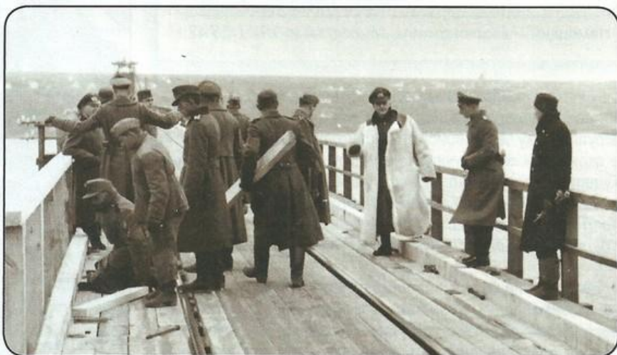
Начальник ж/д перевозок генерал Рудольф Герке на возведенном мосту через Днепр, осень 1941 г.
