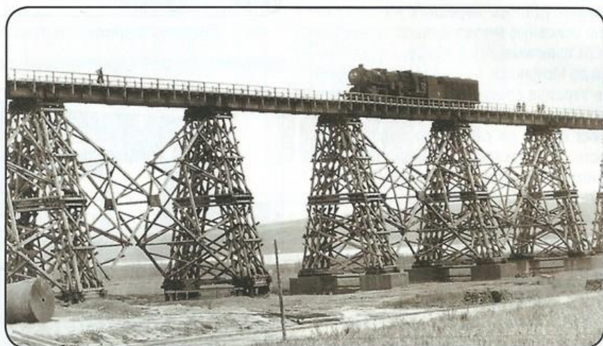
Возведенный немцами временный мост между Казатином и Жмеринкой, Украина, 1943 г. Кстати, на мосту стоит паровоз с конденсацией пара (увеличенный пробег без дозаправки воды)
