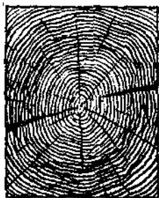
4. Трещины в брусках при сердцевине в центре
