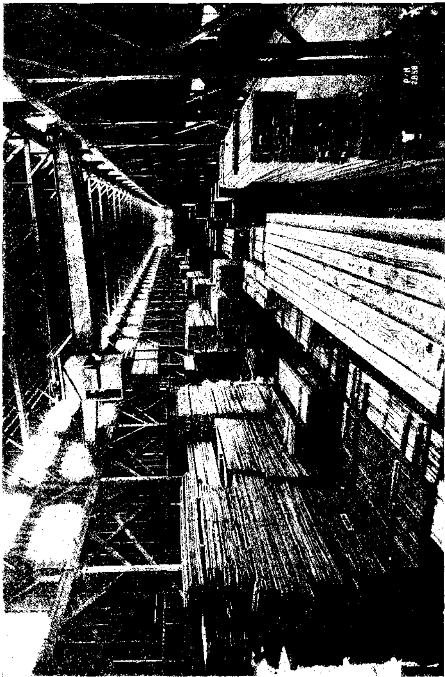
Фиг. 233. Лесной склад, оборудованный грейферным краном.
