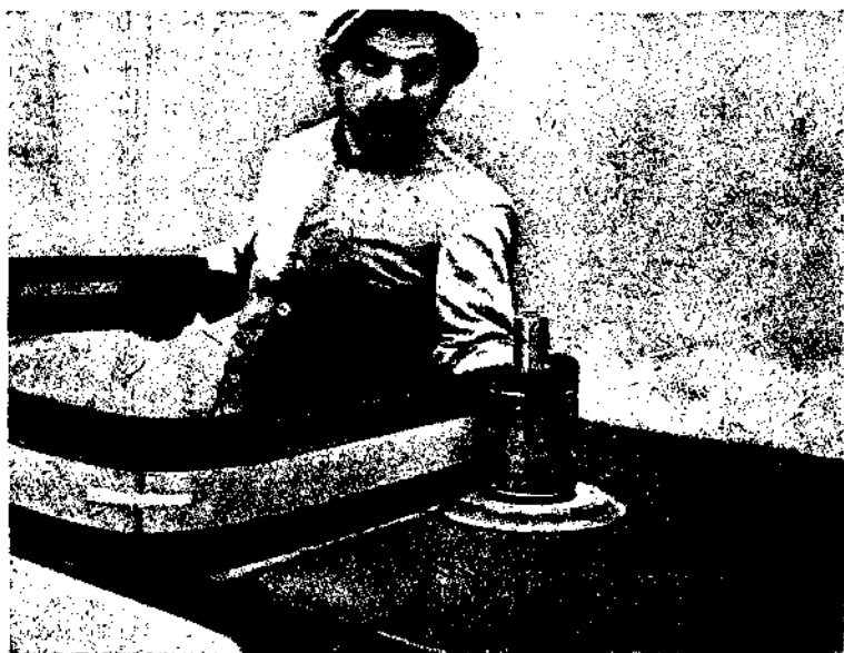
Фиг. 195. Обработка крупных криволинейных частей на фрезерном станке при помощи специальных колодок и направляющих колец.
