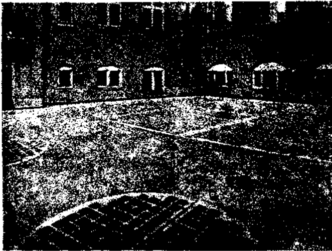
Фиг. 182. Освещение поддворового пространства стеклами Кеплера.
