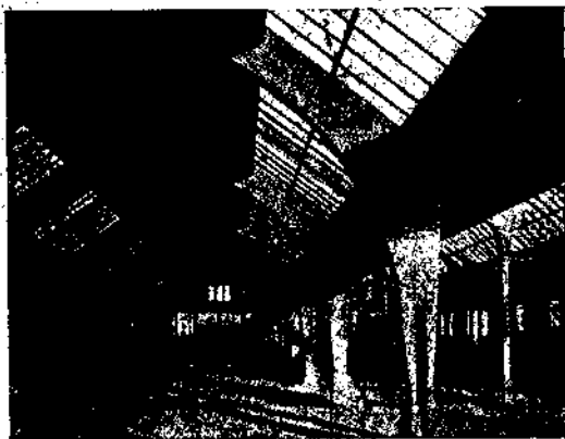
Фиг. 95. Освещение боковыми продольными фонарями вагонного парка трамвая в Дюссельдорфе, Германия.
