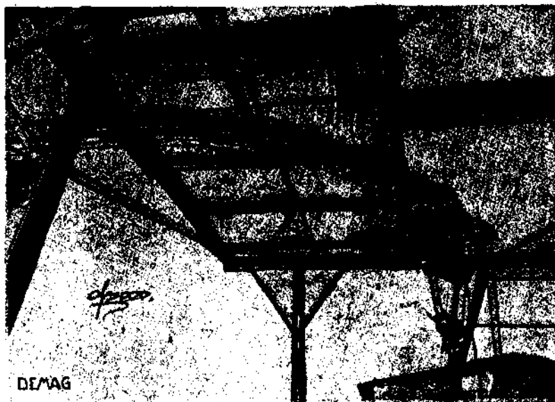
Фиг. 305. Подвеска двутаврового монорельса к фермам или встакдам.
