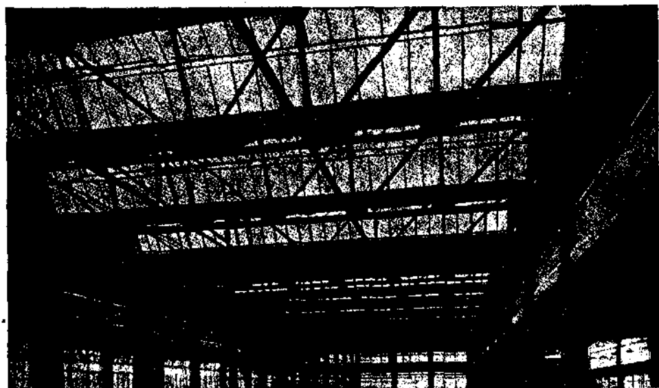
Фиг. 105. Освещение шедовыми крышами.
