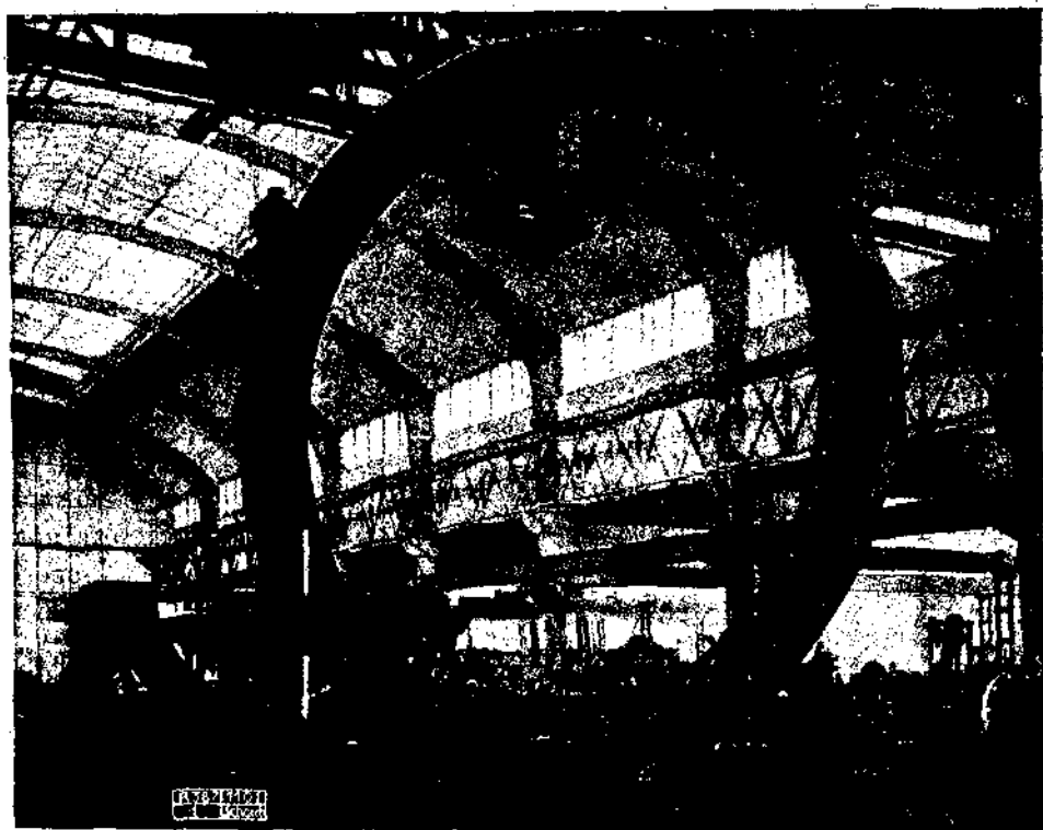
Фиг. 283. Совместная работа двух мостовых кранов, смонтированных на одном и том же пути.
