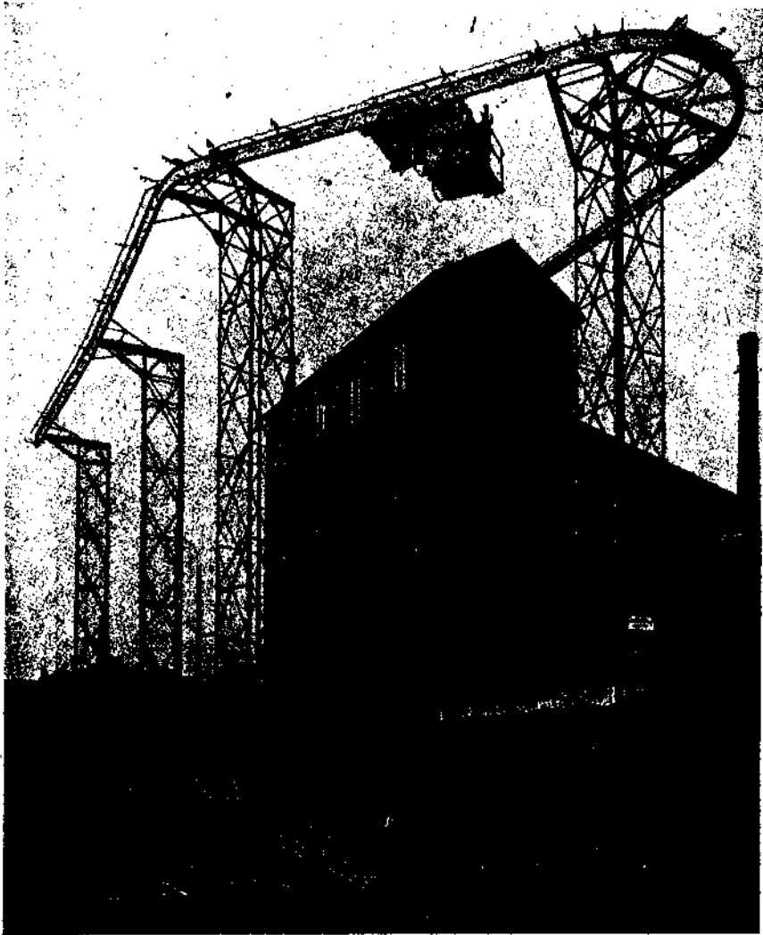
Фиг. 312. Способ прикрепления монорельса подвесной дороги.
