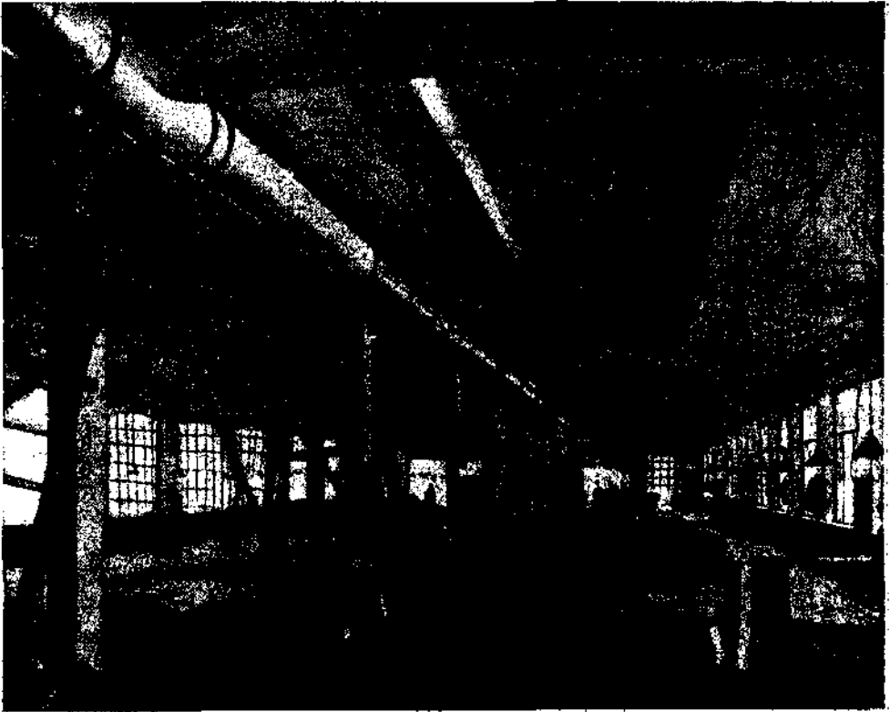
Фиг. 217. Подвешивание воздухопроводов в рабочем помещении.
