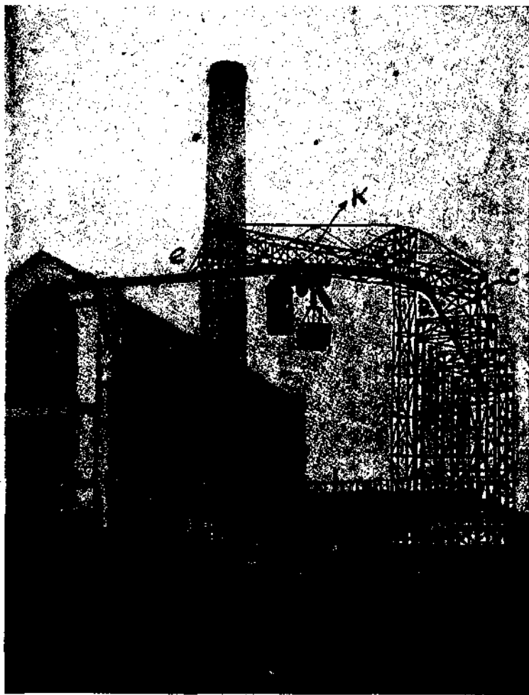
Фиг. 311. Подвижная монорельсовая дорога и способ подвешивания.
