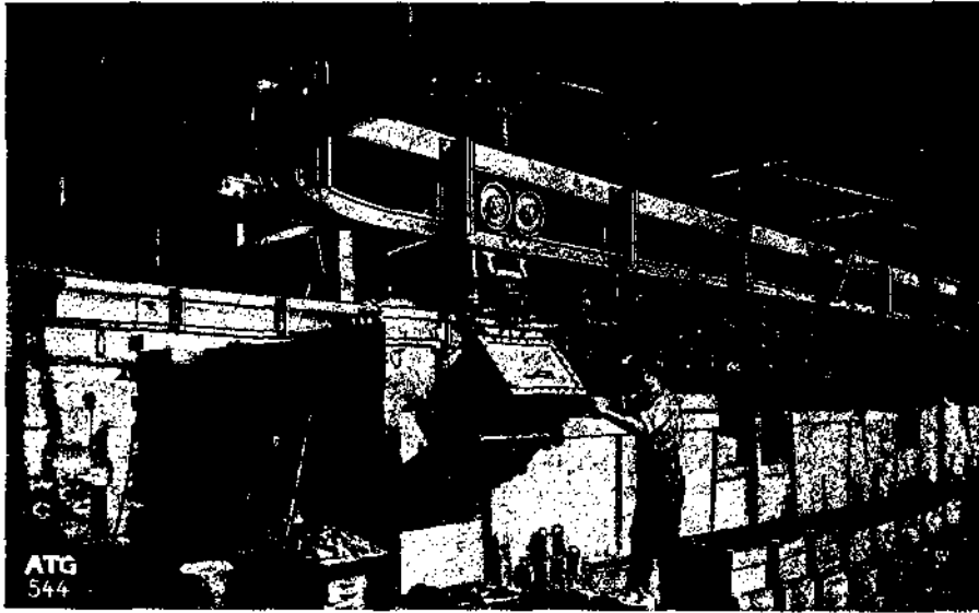
Фиг. 304. Крепление швеллерных монорельсов.
