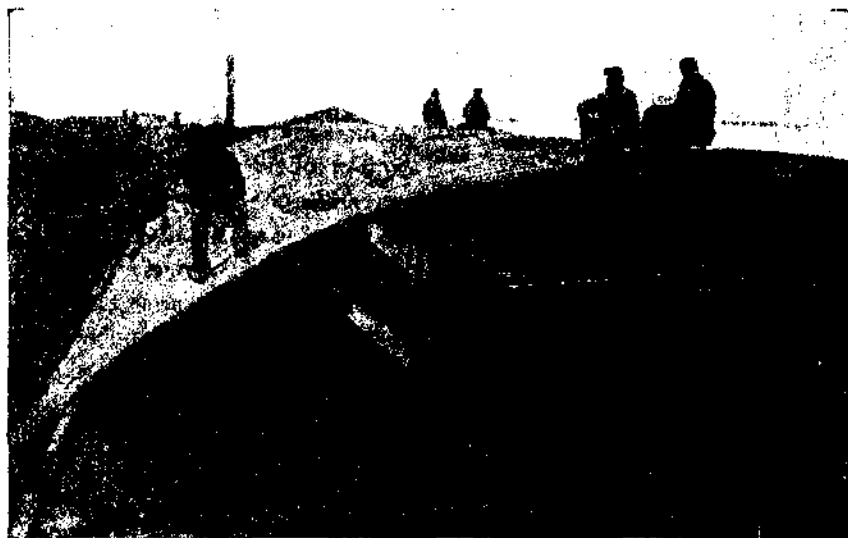
Фиг. 91. Перекрытие склада волнистым железом.
