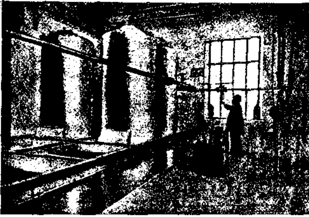
Фиг. 99. Бутылки с инертным газом на складе бензина.
