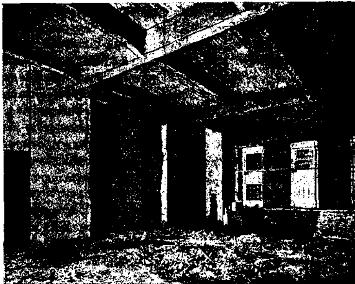
Фиг. 483. Ребристое железобетонное перекрытие.
