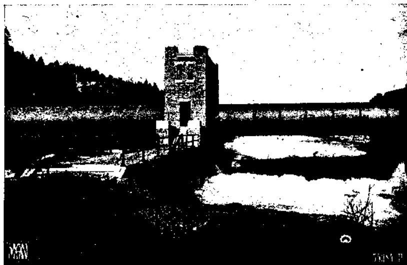
Рис. 34. Плотина с цилиндрическим затвором у Трольгатана.
