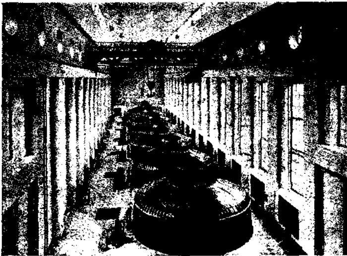
Рис. 32. Внутренность гидроэлектрической станции.
